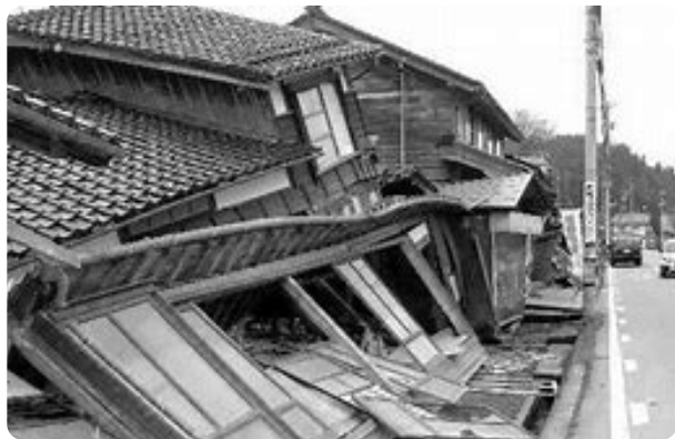
倒壊した家屋
